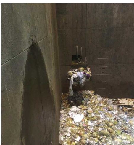
燃えるゴミの攪拌作業風景
